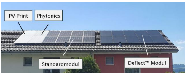
Abbildung 5: Übersicht der PV-Module aus dem Pilotprojekt [3].
