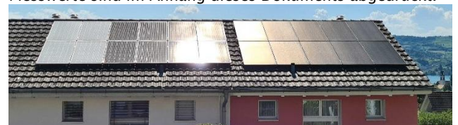
Abbildung 4: Blendende PV-Anlage, bei der 4 Module (links) mit Folien zur Reduktion der Blendung bestückt sind (Quelle: [2] und [3]).
